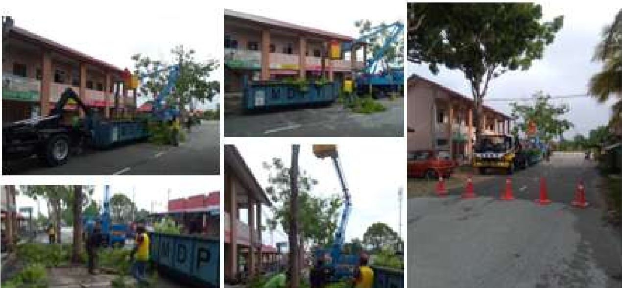
Kerja – kerja penebangan pokok di Masjid As- Siddiq pada 18 Mac 2020
