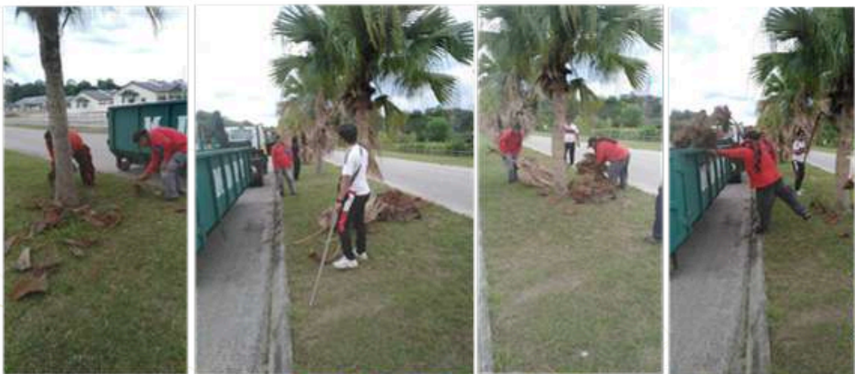
Penyelenggaraan pokok di Jalan Teknologi I pada 17.08.23 ▲
